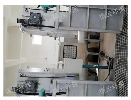
阶梯式网板格栅的性能特点:阶梯格栅是由一种耙齿厂装配成-组回转格栅链。在电机减速器的驱动下,耙齿链进行逆水流方向回转式运动。耙齿链运转到设备的上部时,由于槽轮和弯轨的导向,使每组耙齿之间产生相对自清运动,绝大部分固体物质靠重力落下。另一部分则依靠清扫器的反向运动把粘在耙齿上的杂物清扫干净。按水流方向耙齿链类同于格栅,在耙齿链轴. 上装配的耙齿间隙可以根据使用条件进行选择。当耙齿把流体中的固态悬浮物分离后可以保持水流畅通流过。整个工作过程是连续的,也可以是间歇的。格栅运行时,温度高而震动并不大。江苏格栅安装
