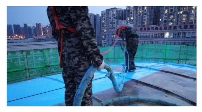
聚脲是由异氰酸酯组分与氨基化合物组分反应获得的一种弹性体。由于聚脲的反应原理与聚氨酯类似,且应用形式和领域也基本一致,因此广义的聚氨酯往往将聚脲包含在内,统称为聚氨酯。从分子结构上,聚氨酯与聚脲也有相似之处,因为常用的双组分聚脲也往往利用羟基与异氰酸根的反应进行预聚改性,因此分子结构中含有氨酯基结构。一般来说,将由异氰酸根与氨基反应完成固化反应的材料称为聚脲材料。聚脲的一大特点是其固化反应速度快,异氰酸酯同各种活泼氢化合物的相对反应速度如表1所示。其中脂肪族伯胺与脂肪族仲胺的反应速度远超其它活泼氢化合物,比异氰酸酯与水的反应要快出2~3个数量级。在实际应用中,快速反应喷涂聚脲的固化时间往往以秒为单位,使其施工效率极高,且受环境湿度影响较小,在潮湿环境下的施工(如隧道、地下工程等)更加具有优势,基本不会受到异氰酸酯与水反应生成二氧化碳的副反应影响而产气泡现象。
